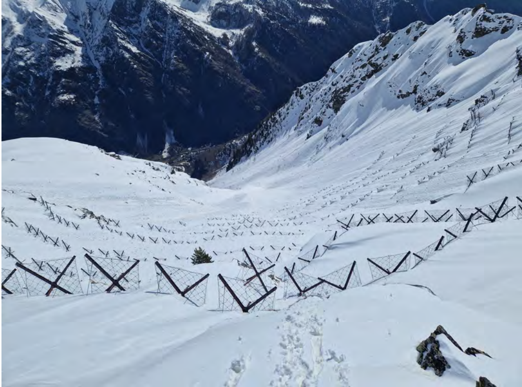
Figura 4.4 - Ombrelli da neve. Bacino della Valnera in Gressoney-Saint-Jean, Valle d'Aosta (Segor, 2024).
